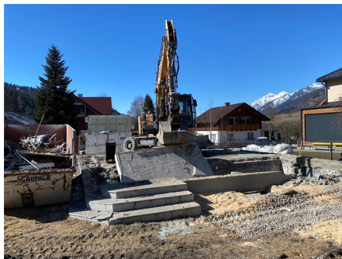
Abb. 3: Entfernung der versiegelten Elemente.
