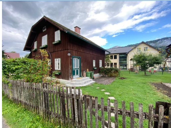
Abb. 2: VORHER: Das Grundstück vor der Entsiegelung.
