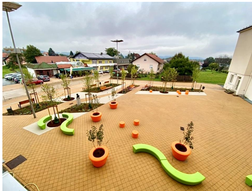
Abbildung 2: Ansicht des entsiegelten & begrüneten Pausenhofs der MS Gleinstätten nach der Umgestaltung vom Schulgebäude aus, ©Klimaregion Sulmtal-Sausal
