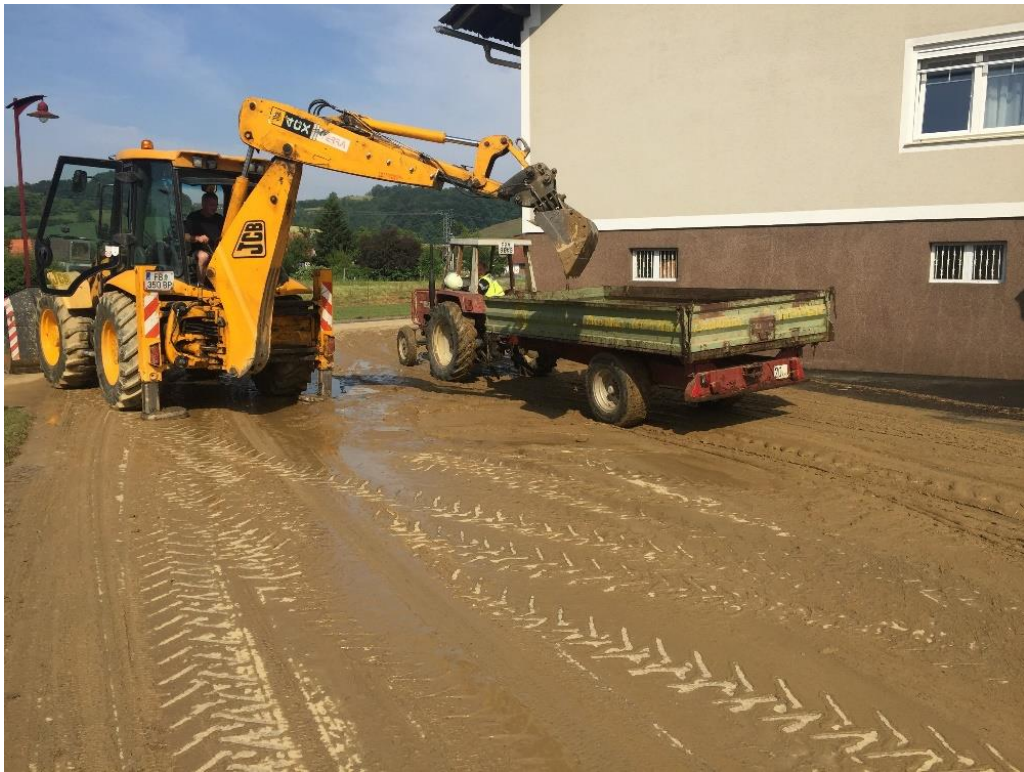
Abb. 18: Erosion in Unterlamm, Mai 2019 (Fotocredit: Bgm. Robert Hammer)
