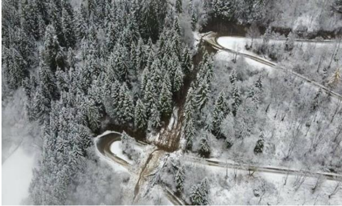
Abbildung 8 Maltabergstraße von Mure verlegt, Rüscher 2019
